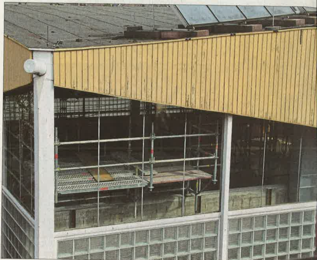
Blick von oben in die Doppelturnhalle, in der die Decken auf gesamter Fläche abgestützt sind.
